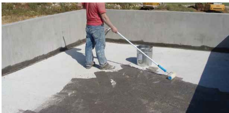
Application of Aquathane Primer PU
